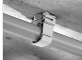
Cable conduits or light duty pipes
